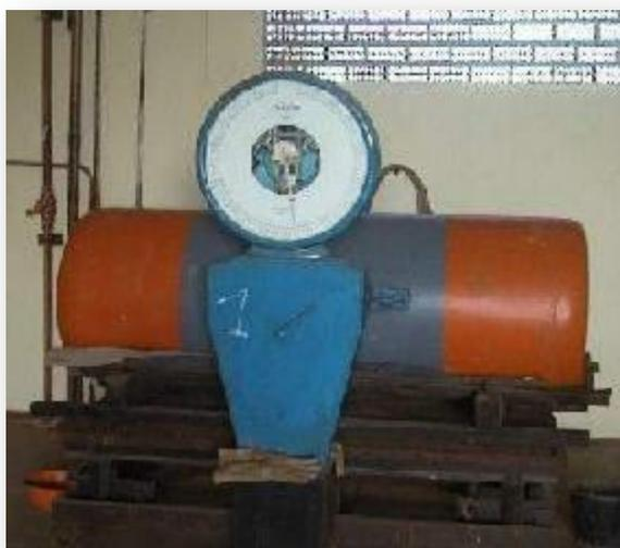
Figura VIII.20 - Balança de cloração para cilindro de cloro gasoso
