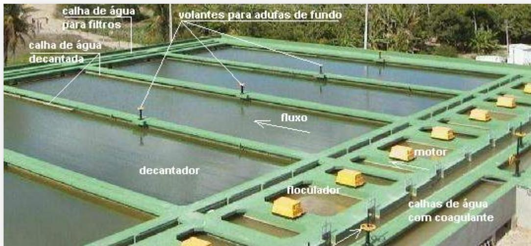
**Figura VIII.11 - Decantador convencional de fluxo horizontal.** ETA Gravatá, CAGEPA, Sistema Boqueirão-Campina Grande.
