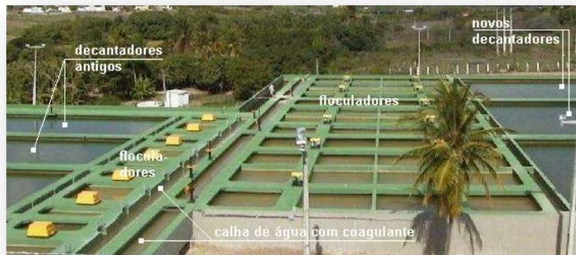
**Figura VIII.9 - Floclador mecânico vendo-se as tampas (amarelas), para proteção do motor de acionamento do misturador. (Ver detalhe na Figura VIII.10). ETA Gravatá, CAGEPA, Sistema Boqueirão-Campina Grande.**
