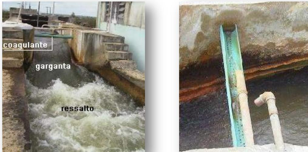
**Figura VIII. 6 - A esquerda foto de uma Calha Parshall em operação como misturador rápido. ETA Gravatá, CAGEPA, Sistema Boqueirão-Campina Grande**
