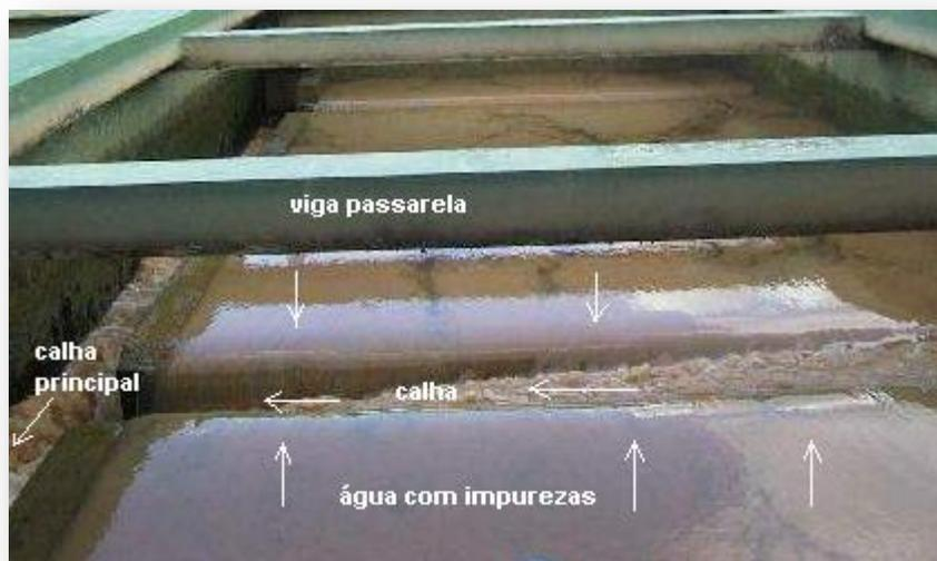
**Figuras VIII.16 - Lavagem de filtros. Na foto de cima o início (areia fluidificando) e na de baixo a lavagem em pleno funcionamento (observar o funcionamento das calhas coletoras)**
