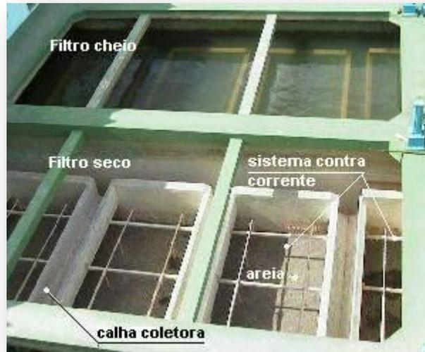
**Figura VIII.17 - Fotografia de um filtro seco onde se vê a malha de tubos do sistema fixo de contracorrente ou lavagem auxiliar**
