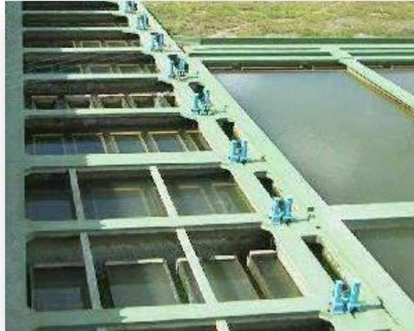
**Figura VIII.15 - Vista parcial da bateria de filtros da ETA Gravatá**
