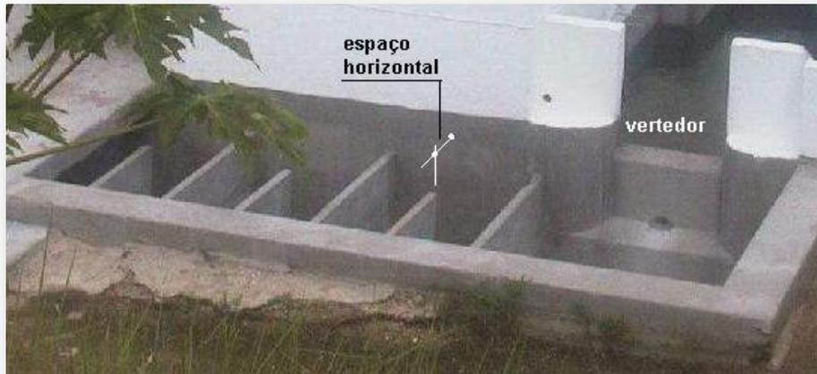
**Figura VIII.8 - Floclador em chicanas verticais (seco) vendo-se, à direita, o vertedor para medição de vazão (ETA Alto Branco, CAGEPA, Campina Grande).**
