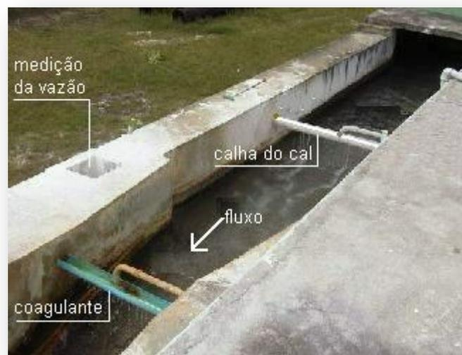
**Figura VIII.7 - Dosador de cal e de coagulante em calha parshall**
